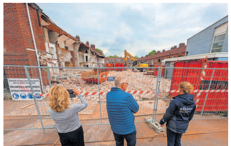
Een woud aan stenen en grote gaten in de huurwoningen aan de Schouwstraat. De sloop van de wijk Het Eiland is begonnen. Projectontwikkelaar Egbert Heida (midden) kijkt toe met rechts projectleider sociaal Helga Hoornveld en links Baukje Bergsma van de communicatieafdeling van Elkien.
